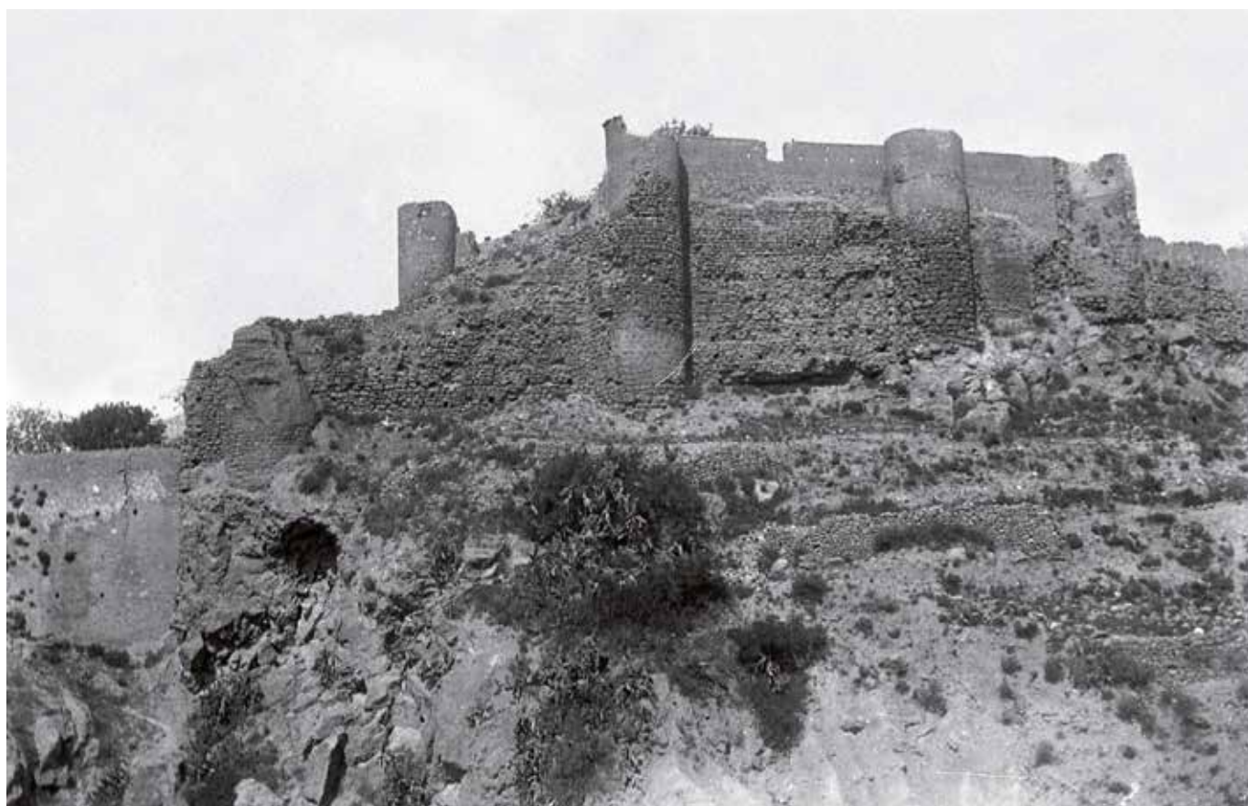
Murallas del castillo de Onda. En ellas se observan claramente los restos de las construcciones islámicas y medievales, a las que se superponen las obras edificadas por el ejército liberal, con sus correspondientes troneras para los fusileros.
